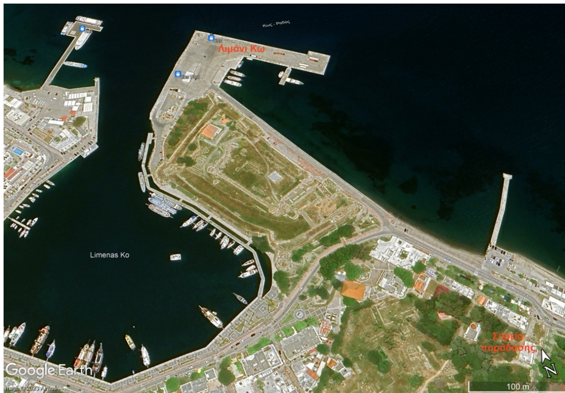
Αεροφωτογραφία της περιοχής όπου εμφανίζεται το σημείο παράδοσης των προϊόντων (εργοτάξιο Μεσαιωνικών Οχυρώσεων Κω).
